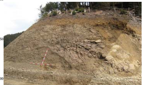
杉沢橋橋台背後の法面に現れた岩盤崩落堆積物
